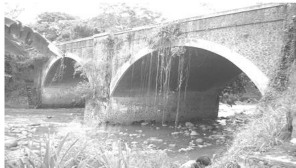
**Gambar 2.** Tipe lengkung lantai urug (jembatan pelengkung lama)
