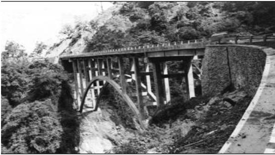
**Gambar 3.** Jembatan tipe lengkung terbuka (Jembatan Besok Koboan)
