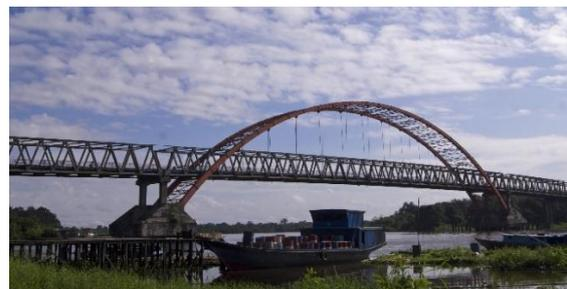
**Gambar 5.** Jembatan lengkung tipe lantai atas dan lantai bawah sebagian
