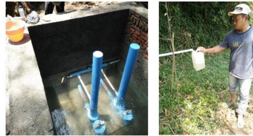
Gambar 6. Setting Pompa dan pengukuran debit output
