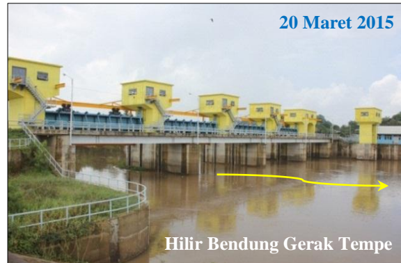
Gambar 1. Bendung Gerak Tempe
