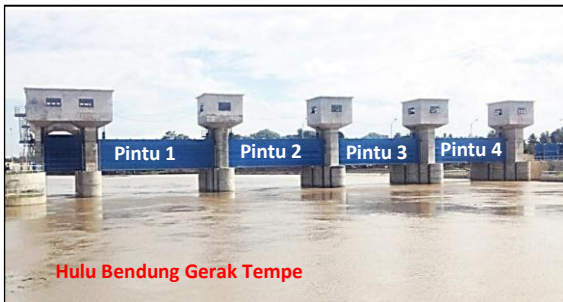
Gambar 23. Penomoran Pintu Bendung Gerak Tempe
