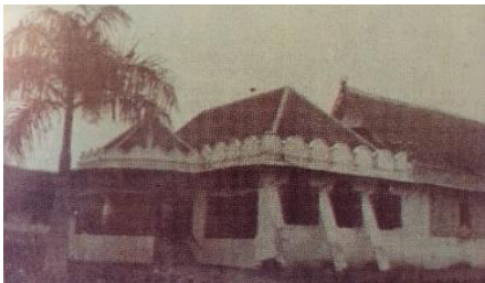
Gambar 4 Kondisi Istana Kesultanan Bima sebelum rekonstruksi
