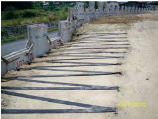
**Gambar 1.** Dinding penahan tanah yang diperkuat dengan geotrap konfigurasi V
