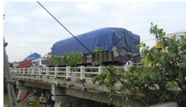
**Gambar 2.b.** Uji pembebanan dinamis
