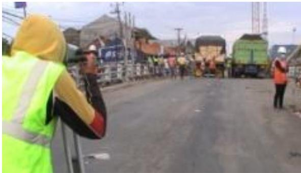
**Gambar 2.a.** Uji pembebanan statis pada Jembatan Ciberes
