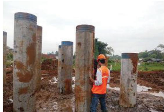
**Gambar 1.** Ilustrasi tiang pancang beton yang sudah di pancang
