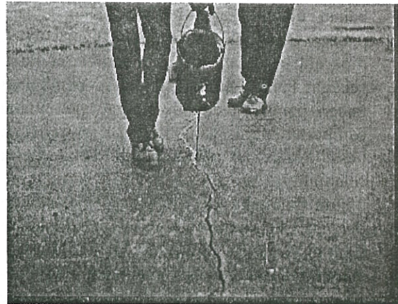
Gambar 1. Pengisian bahan pengisi pada celah retak perkerasan aspal
