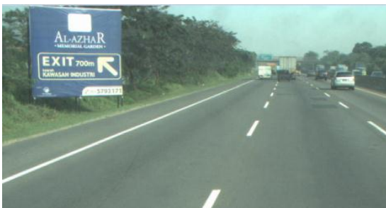
Gambar 15. Perletakan MLG baliho di bahu jalan terlalu dekat dengan lajur lalu lintas (Jagorawi)
