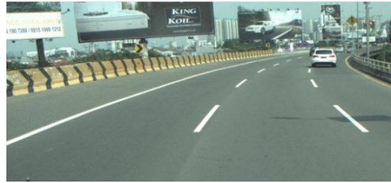
Gambar 16. Perletakan MLG di tikungan pada ruas jalan tol dalam kota (Cawang-Tomang-Grogol-Pluit)
