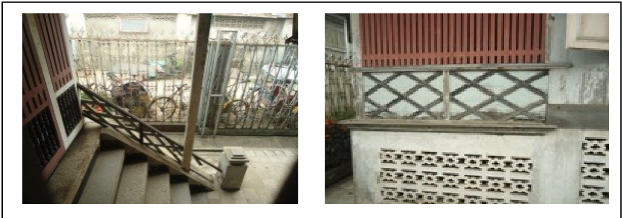
Gambar-15: Railing tangga.
