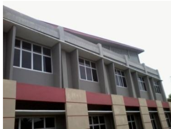
Gambar 5. Gedung aula tampak dari luar
