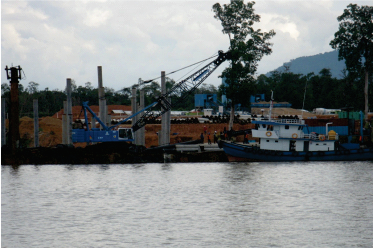
Gambar 3. Pabrik pengolahan Smelter Grade Alumina (SGA) di Mempawah dalam masa konstruksi (September 2011)
