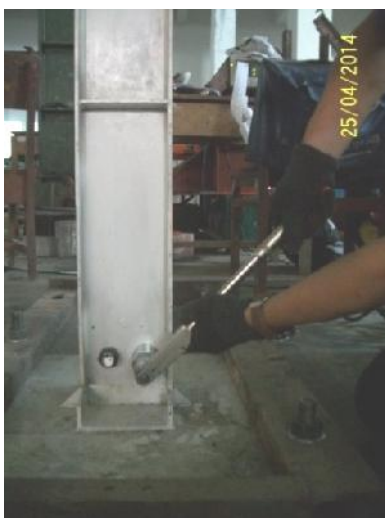
Gambar 6. Pengencangan baut dengan alat ukur
