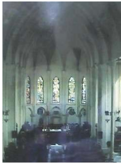
Gambar 4. Sistem vaulting pada langit-langit bangunan
