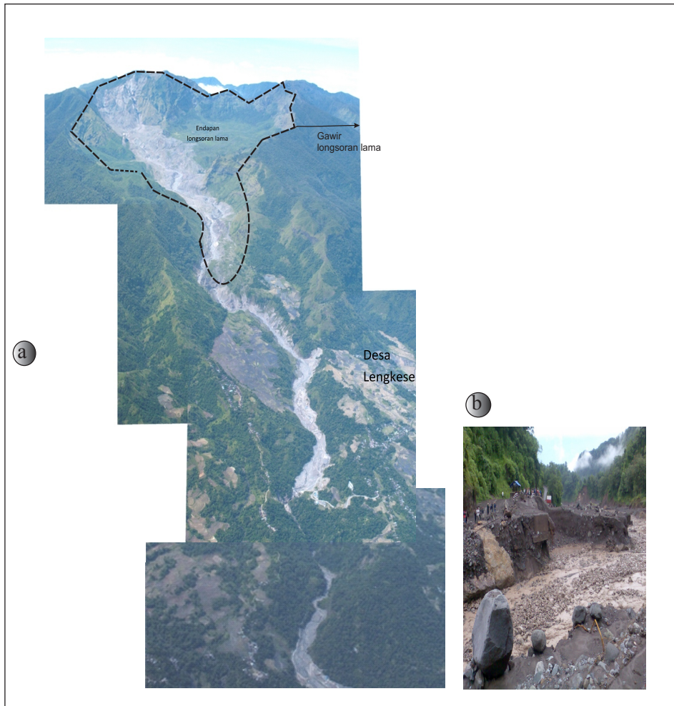
Gambar 4. a. Penyebaran endapan longsoran di bagian barat daya Gunung Bawakaraeng (Departemen Pekerjaan Umum, 2008). dan b. endapan Sungai Jeneberang yang telah menghanyutkan Jembatan Daraha (Pusat Vulkanologi dan Mitigasi Bencana Geologi, 2007).
