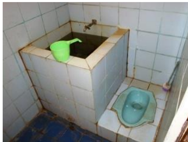
Gambar2. Fasilitas kloset pada wisma hunian lansia (sumber: observasi lapangan)
