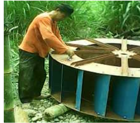
Gambar 10. Pemasangan ring utama yang kedua di atas susunan sudu-sudu menggunakan sambungan baut-mur.
