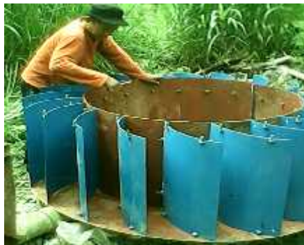
Gambar 9. Roda kincir sistem knock down , tampak proses penyambungan sudu-sudu dengan ring utama dengan menggunakan sambungan baut-mur.
