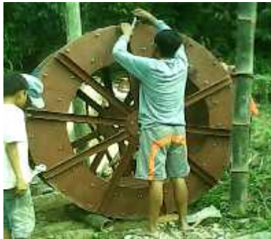
Gambar 13. Penguatan sambungan baut-mur setelah roda kincir dalam posisi berdiri
