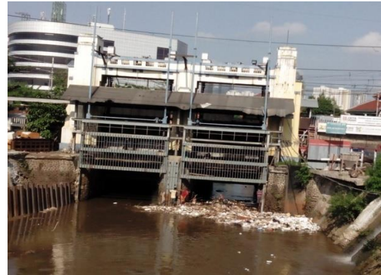
Gambar 1. Pintu Air Manggarai
