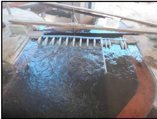
Gambar 14. Kondisi Aliran Pada Hilir Pintu Barrage Dibuka Penuh
