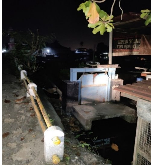
Gambar 5. Kondisi Pintu Air Jl. Belimbing
