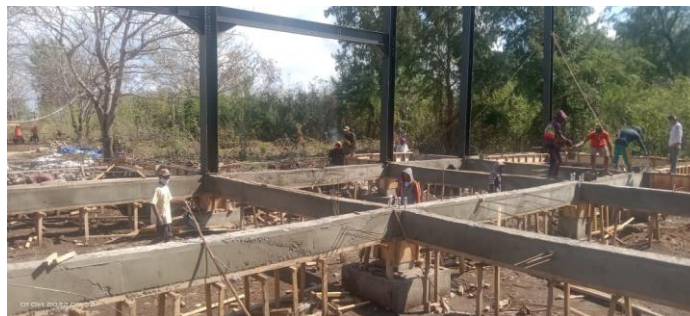
Gambar 4. proses pembangunan struktur baja Rumah Sakit Pratama
