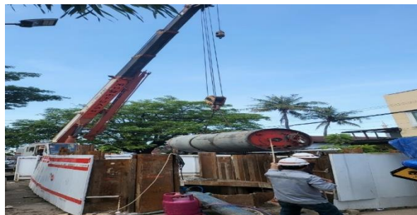
Gambar 3. Pengangkatan Alat Dorong Pipa
