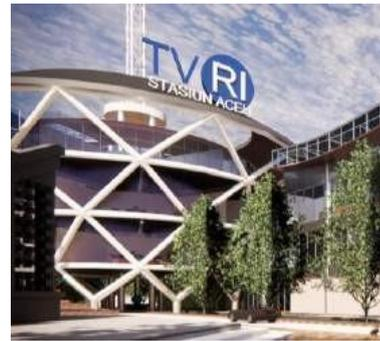
Gambar 14 Penggunaan struktur diagrid pada rancangan TVRI Aceh
