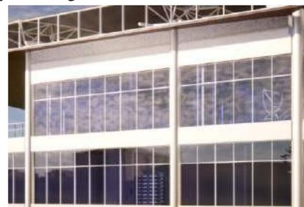
Gambar 8 Material kaca digunakan sebagai dinding eksterior bangunan
