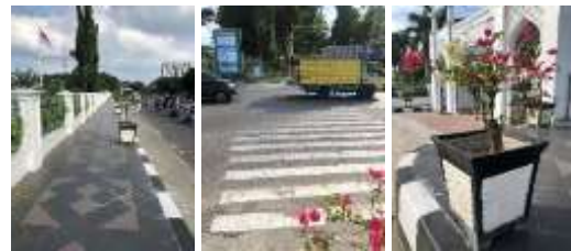
Gambar 5 Kondisi jalur pedestrian di Masjid Raya Baiturrahman (Sumber: Penulis, 2022)
