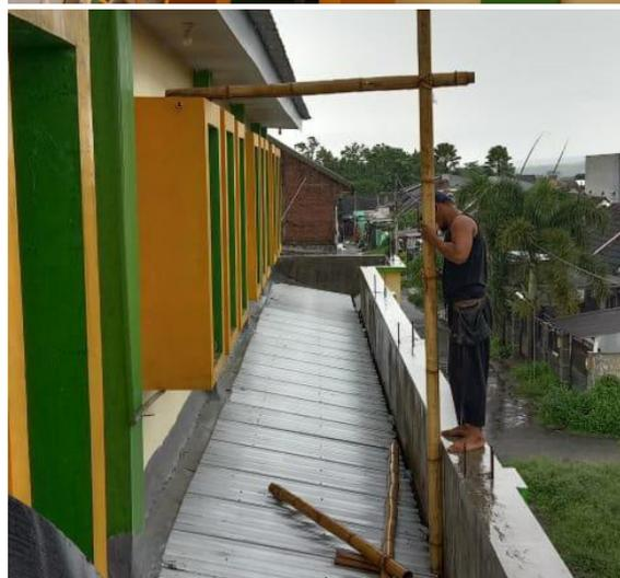
Gambar 7. Proses Pemasangan Talang di Atap Masjid
