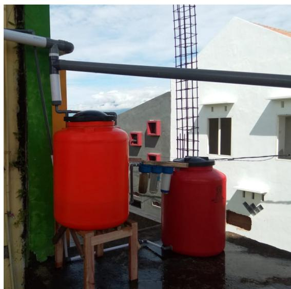
Gambar 8. Dua Buah Tandon Berkapasitas Masing-Masing 350 Liter, Filter di Antara Kedua Tandon, dan Pipa-Pipa PVC
