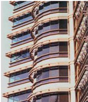
Gambar 2. Selubung Kaca Fasad Bangunan Sumber: www.dupont.com , 2001
