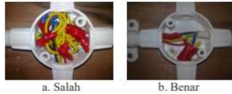
Gambar 10. Sambungan dengan Isolasi Lakban
