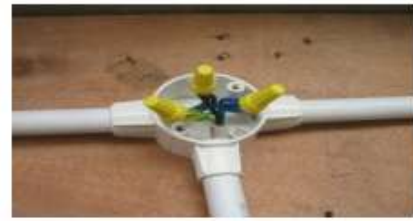
Gambar 9. Sambungan Kabel dengan Lasdop
