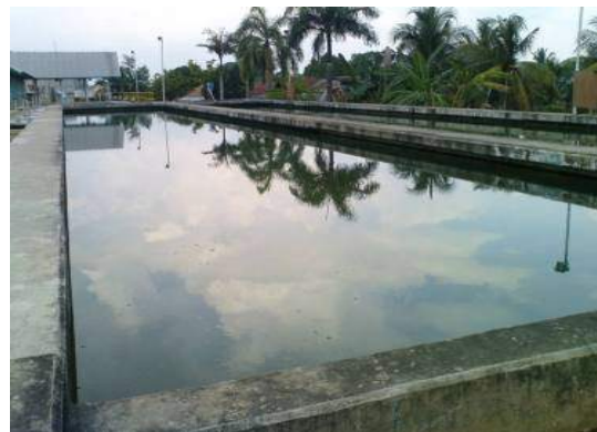
Gambar 5. Bak Sedimentasi
