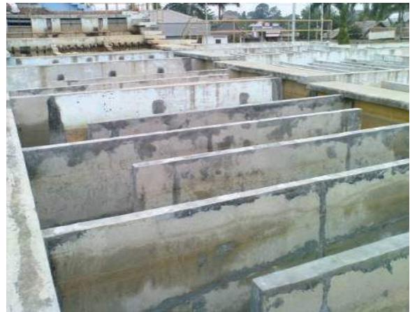
Gambar 4. Bak Flokulasi
