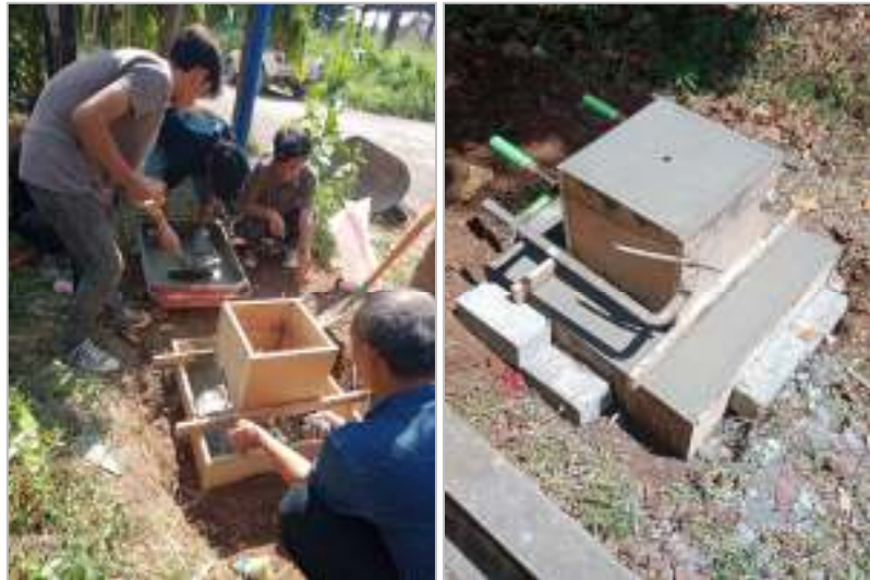
Gambar 1 Aktifitas pembuatan titik BM
