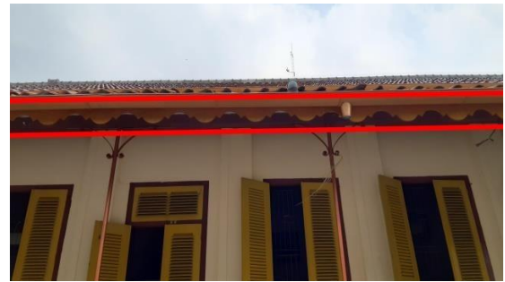
Gambar 10: Lisplank Pada Bangunan SMPN 16 Sumber : Dok.Penulis , 2020
