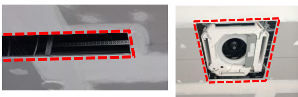
Gambar 8. Pemasangan MEP (Sumber: Data Proyek, 2023)
