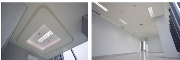
Gambar 9. Finishing Plafond (Sumber: Data Proyek, 2023)
