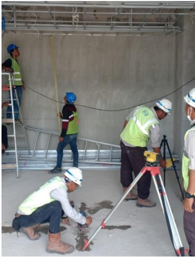
Gambar 7. Starting Point (Sumber: Data Proyek, 2023)
