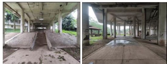
Gambar 4. Kondisi Eksisting Basement Ruang Komunal
