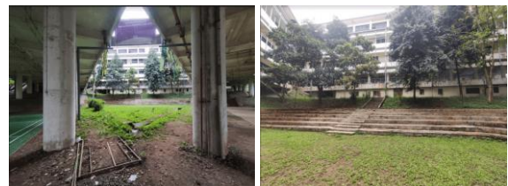
Gambar 5. Kondisi Eksisting Amphitheater Ruang Komunal
