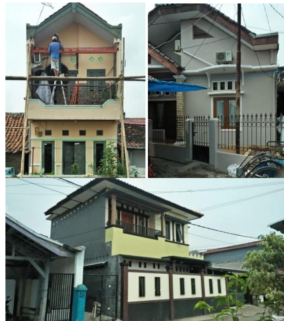
Gambar 11. Kondisi Rumah pada RW.04 Sumber : Dok.Penulis 2019
