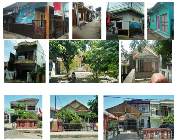
Gambar 7. Kondisi Rumah pada RW.02 Sumber : Dok.Penulis 2019
