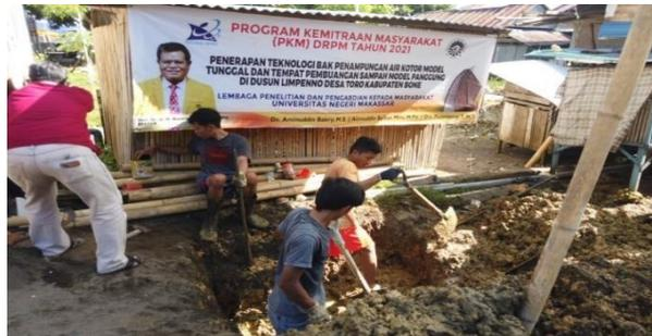
**Gambar 3. Proses pengerjaan pembuatan Konstruksi Bak penampungan model tunggal.**
