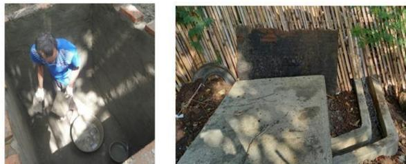
**Gambar 4. Proses Pemasangan dinding Bak dan Hasil akhir pembuatan Bak penampungan model tunggal.**
