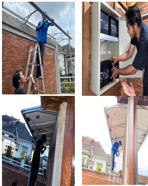
Gambar 3. Proses pembangunan sistem PLTS.
