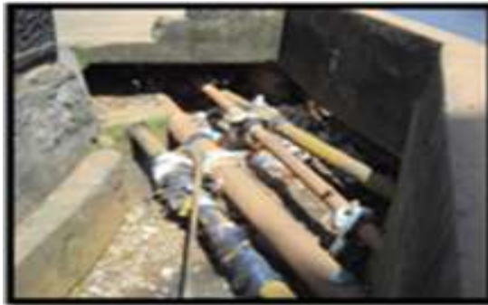
Gambar 7. Pipa-Pipa Air Yang Dipasang Di Dalam Saluran Drainase
