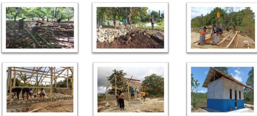
Gambar.3 Kegiatan Pembangunan Rumah PAUD di Dusun 3
