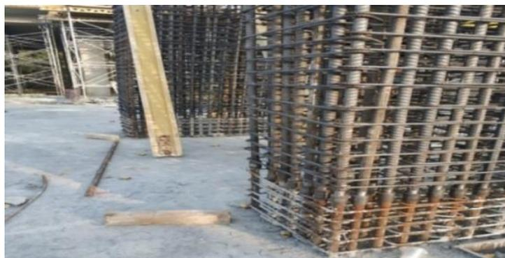
Gambar 13. Pembesian Kolom dengan metode sambungan *Coupler*
