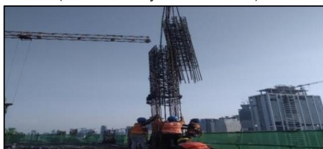
Gambar 14. *Erection* tulangan kolom dengan menggunakan bantuan *tower crone* (Sumber: Proyek *The stature*)
