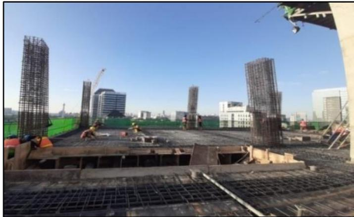
Gambar 15. Pembesian Kolom dan plat lantai dengan metode *Lapsplince/overlap* (Sumber: Proyek *The Stature*)
