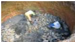
Gambar 2 Proses Penggalian Pembuatan Digester
