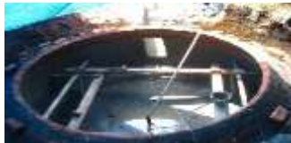
Gambar 3 Proses Penyemenan Digester
