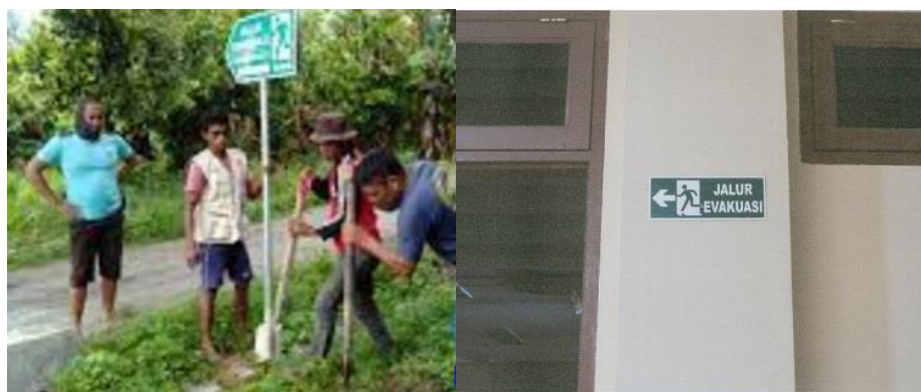
Gambar 2. Pemasangan Petunjuk Jalur Evakuasi
