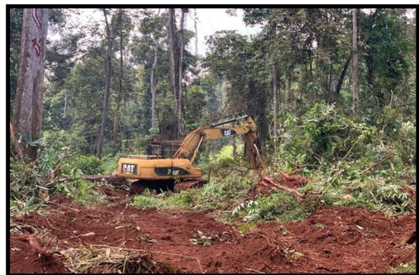
Gambar 2. Proses kegiatan pembuatan jalan tambang (*land clearing*)
