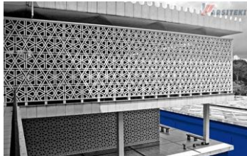
Gambar 5 Roster beton pada bangunan
