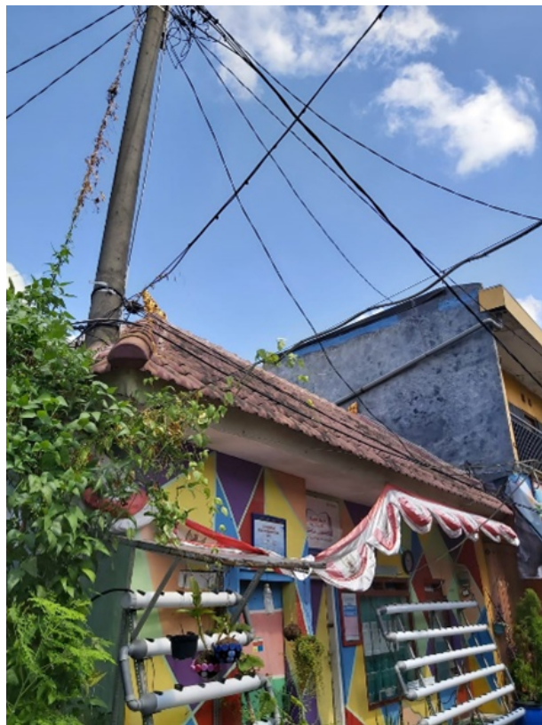
Gambar 3 Tempat Panel akan dipasang.
