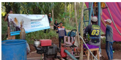
Gambar 6. Pembangunan Pengeboran Sumber Air (b)
