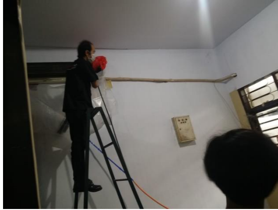
Gambar 3. Pembersihan indoor AC split
