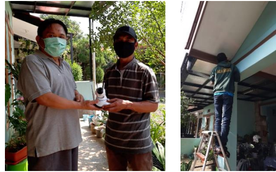
Gambar 9 Serah terima dan pemasangan perangkat
