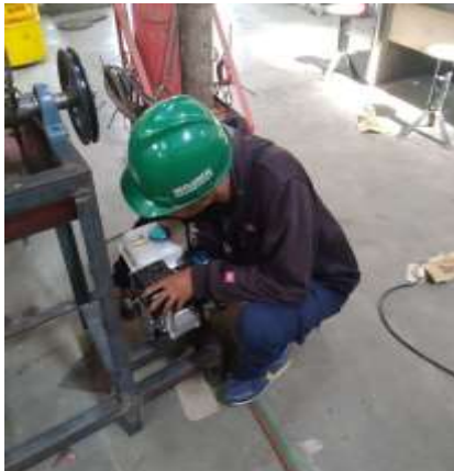
Gambar 8. Pemasangan motor bensin
