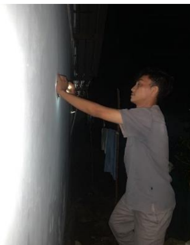
Gambar 7. Pemasangan penerangan jalan berbasis energi terbarukan.
