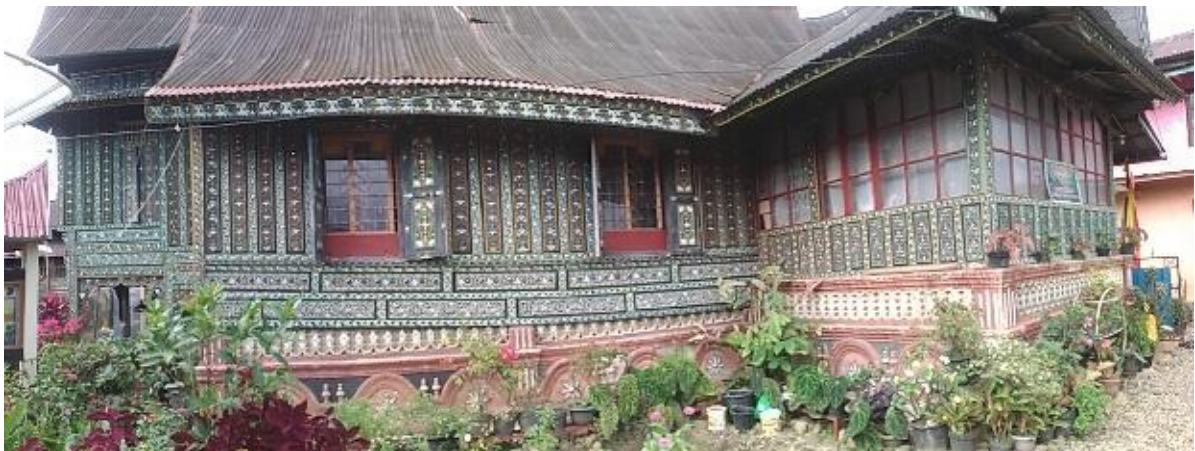
Gambar 8. Tampak Luar Dinding yang Sudah Mengalami Modernisasi (Sumber : Dokumentasi Pribadi)
