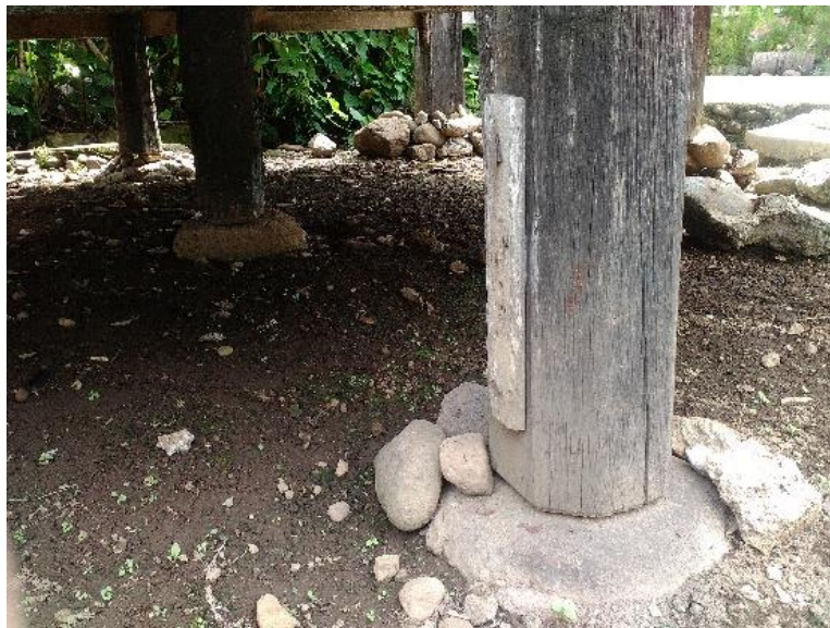
Gambar 6. Pondasi batu umpak (Sumber : Dokumentasi Pribadi)
