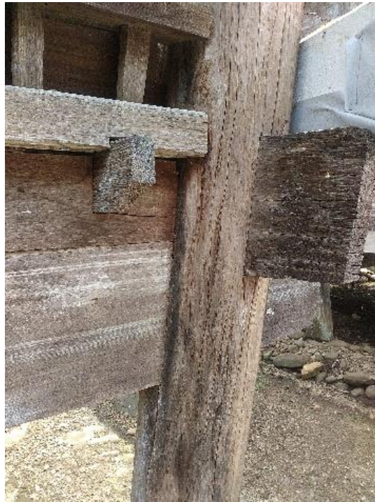
Gambar 7. Sambungan Pasak pada Rumah Gadang (Sumber : Dokumentasi Pribadi)
