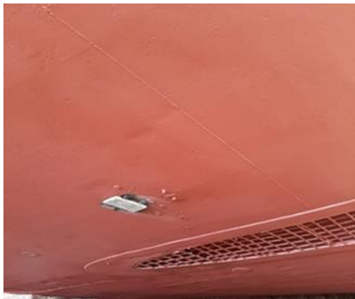
Gambar 5: Zinc anode yang telah terpasang
